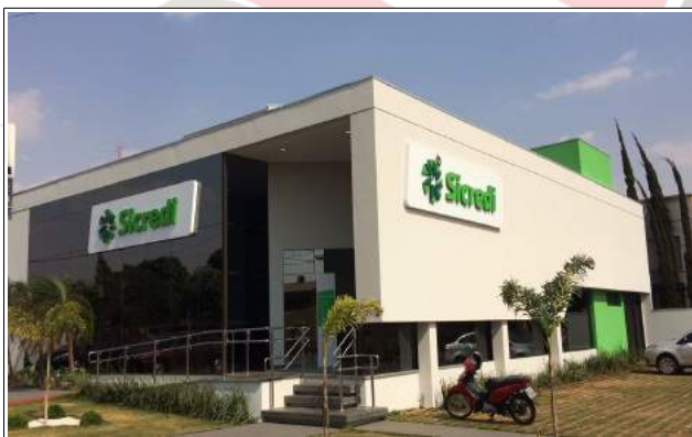
BANCO SICREDI – Rua Rio Branco – 1329 – Centro – próximo ao Supermercado Ki-Carne.
